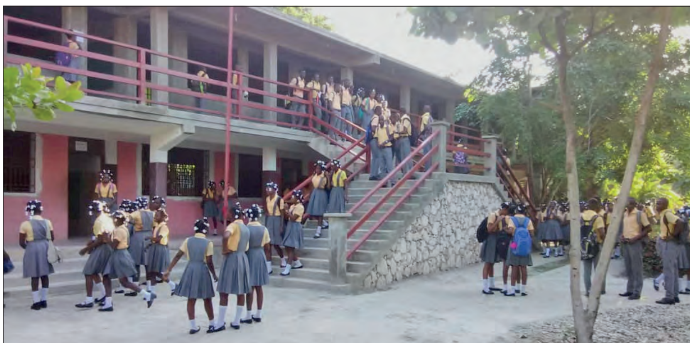
Der zweite Stock der Schule wurde komplett angebaut, mit nunmehr weitere sechs Klassenräume
